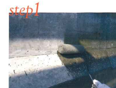
プライマー塗布
